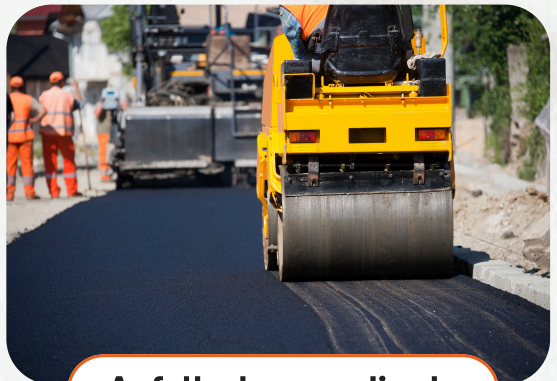
Asfaltado en caliente
